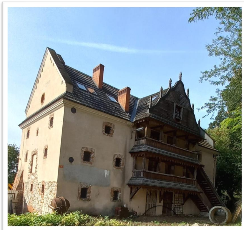
Spichlerz - wzniesiony w 1696 r., a później przebudowany w XIX w.
