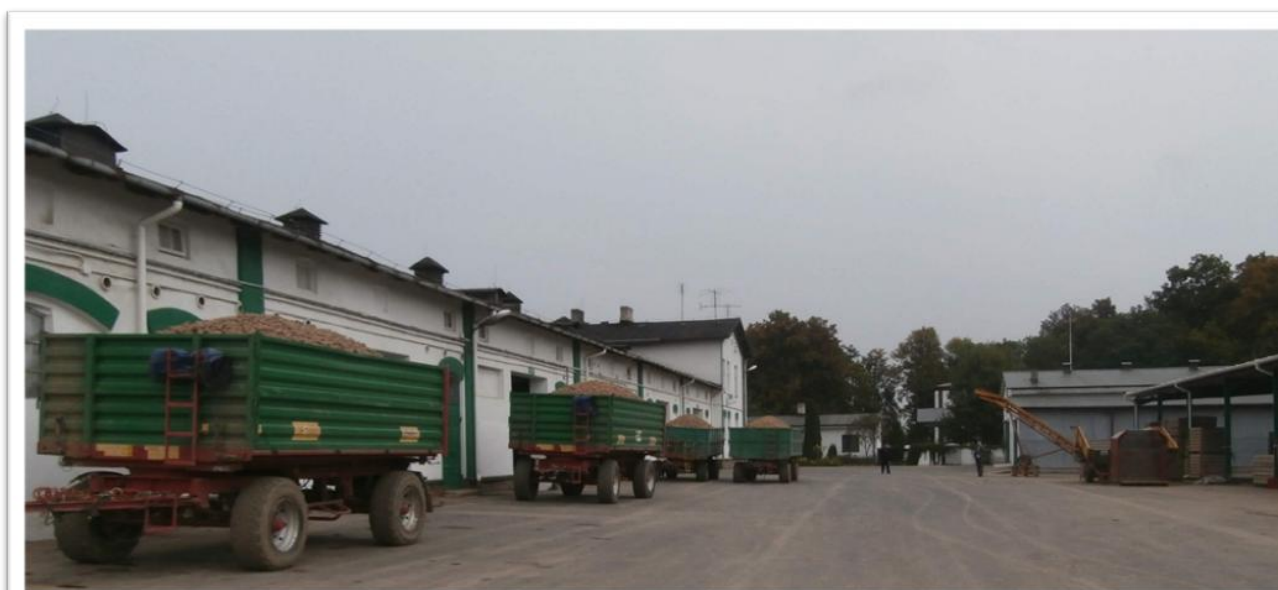
Zaplecze techniczne Stacji Doświadczalnej
