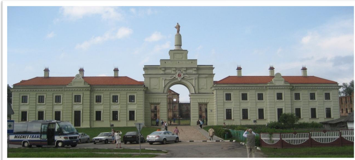
Brama wjazdowa (wyremontowana) pałacu Sapiehów w Różanie
