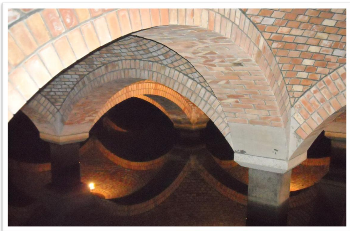
Wnętrze filtra powolnego napelnionego wodą
