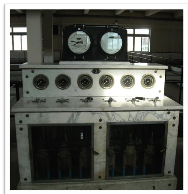
Przełączniki poszczególnych sekcji wraz z wskaźnikami
