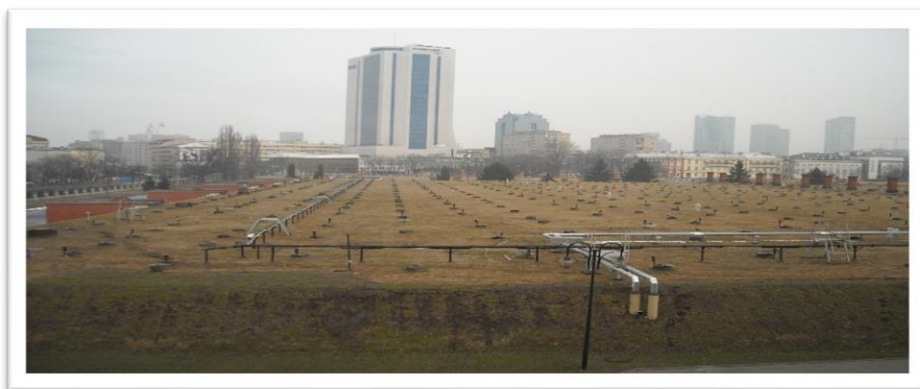
Teren Stacji Filtrów
