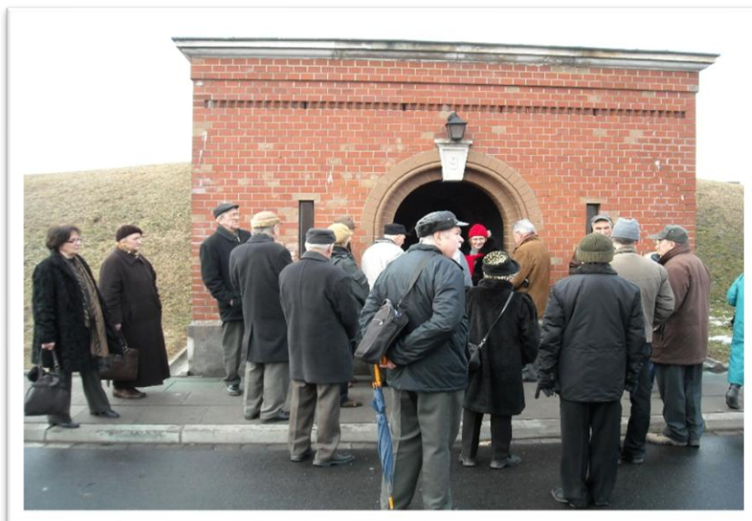
Wejście do filtrów powolnych
