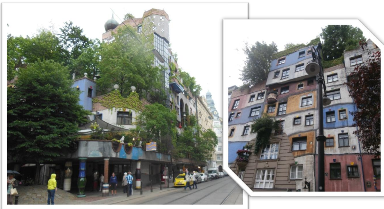
Dom Hundertwassera w Wiedniu. Budynek mieści 50 mieszkań (o powierzchni od 30 do 150 m 2 ), na tarasach, balkonach i w innych niespodziewanych miejscach rośnie wiele roślin.
